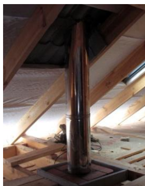
Фото 4. Труба на чердаке
