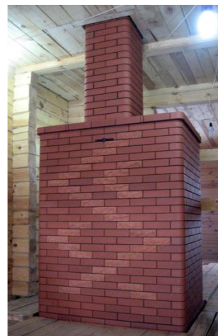
Фото 3. Печь второго этажа (вид сзади)
