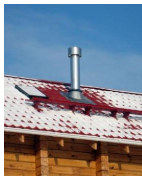
Фото 5. Труба на кровле
