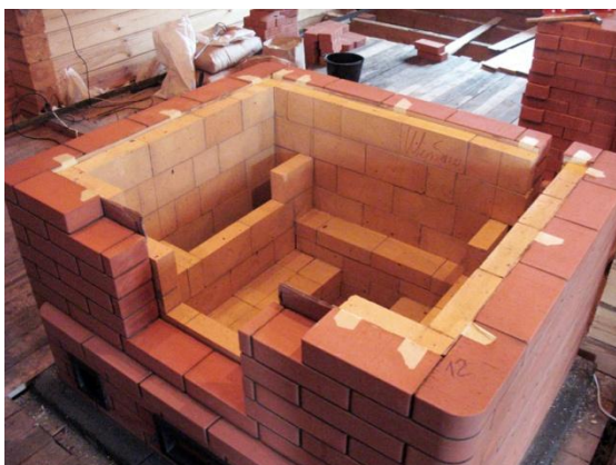
Фото 8. Строительство двенадцатого ряда печи
