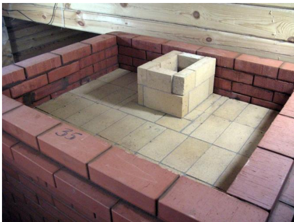
Фото 11. Строительство тридцать пятого ряда печи
