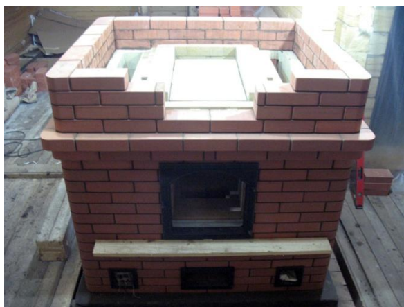
Фото 10. Строительство двадцатого ряда печи
