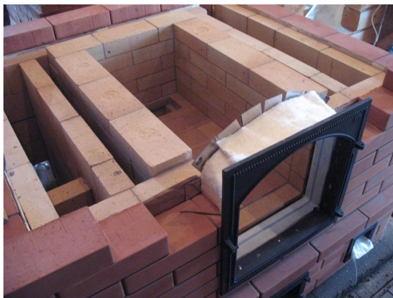
Фото 9. Установка дверцы топки
