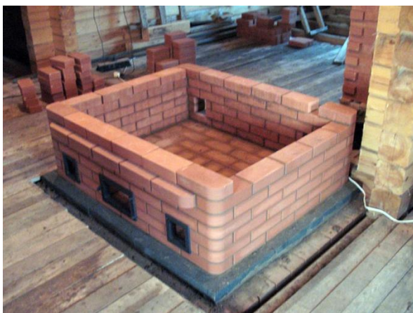
Фото 7. Строительство седьмого ряда печи
